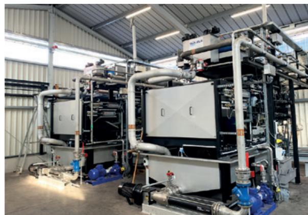
Die Sülzle Klein GmbH wurde von einem großen Stahlhersteller mit der Entwicklung und Lieferung von zwei Bandfilterpressen samt Peripherie beauftragt. Das Ziel: Eine umweltfreundliche und weitgehend automatisierte Gichtschlammwässerung. Ein zentraler
